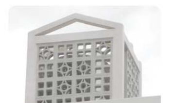
貯水タンクを花ブロックで囲い、景観に配慮した例
