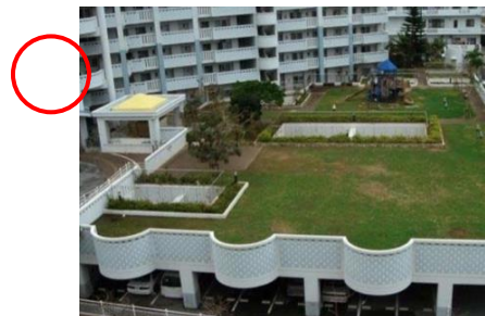
芝生により緑化された事例（県営住宅立体駐車場）
