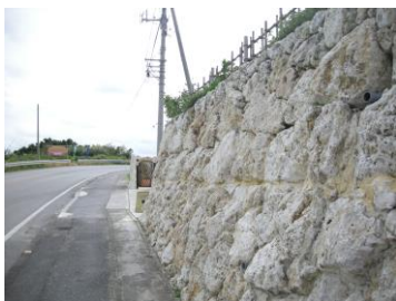
石積み擁壁の事例
