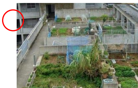
菜園として緑化された事例（那覇市営住宅）
