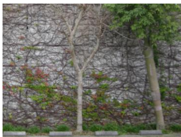
ツル類による壁面緑化や、樹木による前面緑化を行った事例
