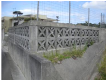
花ブロック・穴あきブロックで修景した事例
