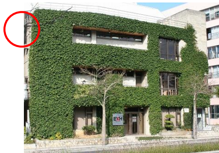
壁面にツル類を直接植栽した事例（浦添市内）
