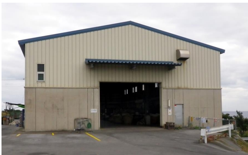
写真 2.1 島尻消防、清掃組合 スtockヤードの外観
