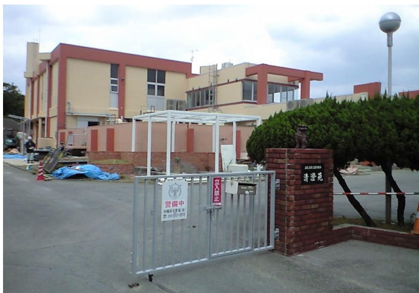
写真 3.1 島尻消防、清掃組合 清澄苑し尿処理施設の外観
