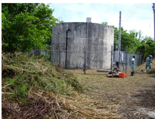
C配水池 RC造 V=221.17\text{m}^3 (昭和52年1月建設)
