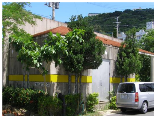
佐敷第2送水ポンプ P=18.5kw-2台
