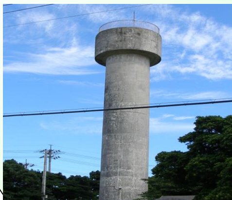
親慶原高架水槽 34m 3 昭和 52 年建設
