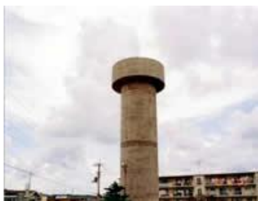
嶺井団地高架水槽 RC造 V=100\text{m}^3 (昭和58月度建設)
