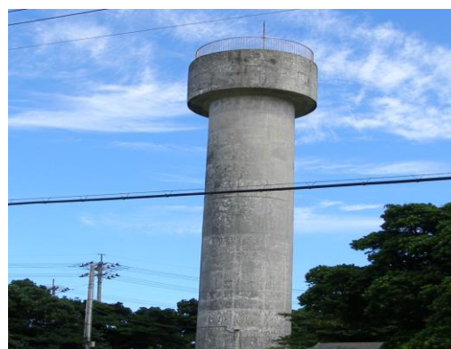
親慶原高架水槽 RC造 V=34.18\text{m}^3 (昭和52年1月建設)
