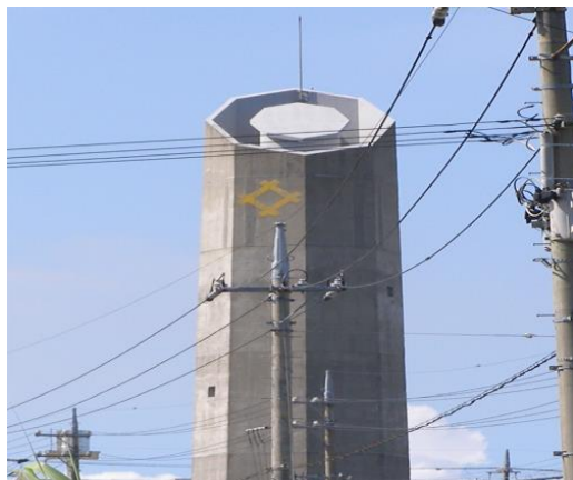
つきしろ高架水槽 PC造 V=50\text{m}^3 (平成9年3月建設)
