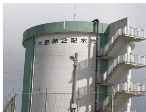
大里第2配水池 PC造 V=1,000m 3 (昭和62年度建設)
