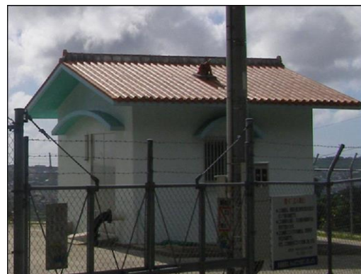
大里中継ポンプ場 RC造 P=37kw-2台 (平成15年度建設)
