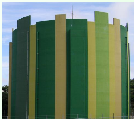
佐敷第1配水池 2,100m 3 平成11年建設
