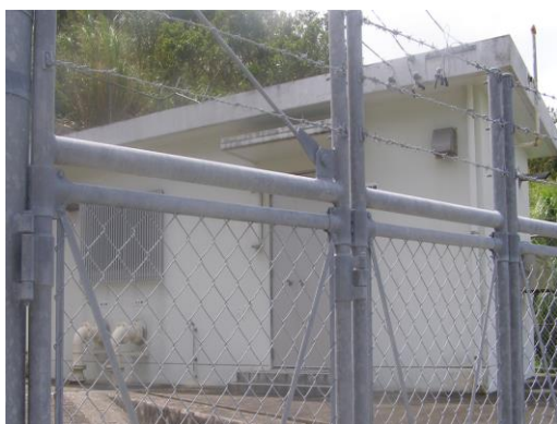
稲福増圧ポンプ場 RC造 P=2.2kw-2台 (平成8年度建設)
