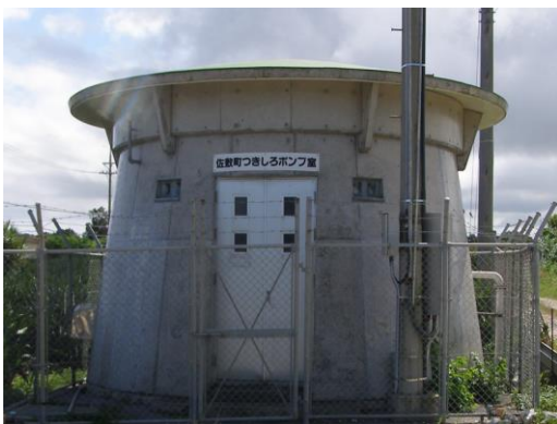
つきしろポンプ室 RC造
