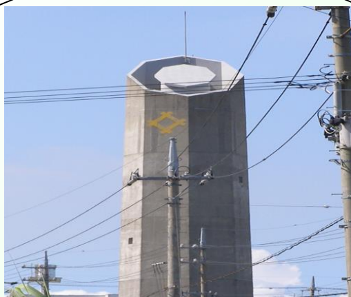
つきしろ高架水槽 50m 3 平成9年建設
