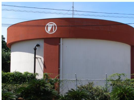
久手堅配水池 427m 3 昭和 63 年建設
