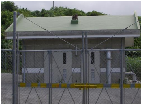
糸数送水ポンプ室 RC造 (平成11年3月建設)
