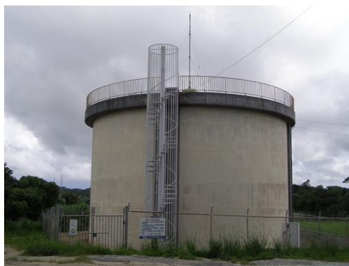
大里第1配水池 PC造 V=1,500m 3 (昭和54年度建設)
