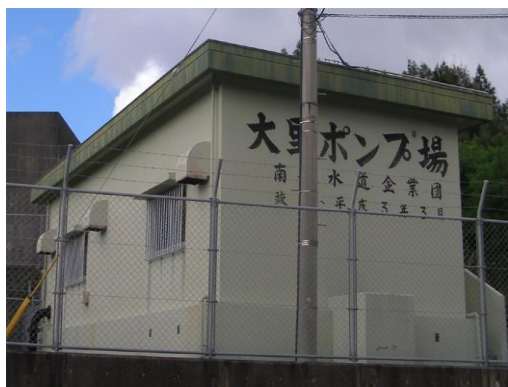
大里ポンプ場 RC造 P=30kw-3台 (平成2年度建設)
