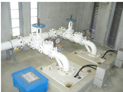
佐敷第2送水ポンプ室 RC造
