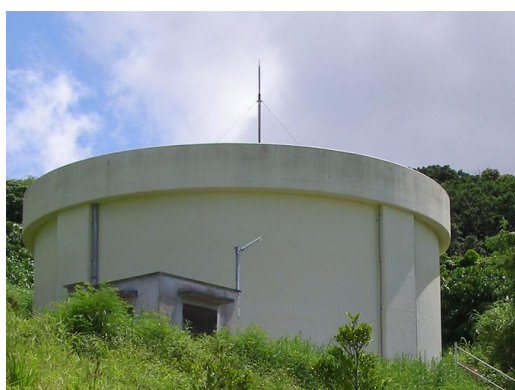
佐敷第2配水池 PC造 V=800\text{m}^3 (平成10年3月建設)
