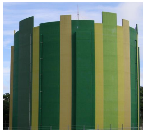
佐敷第1配水池 PC造 V=2,100\text{m}^3 (平成11年2月建設)
