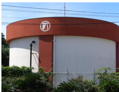
久手堅配水池 PC造 V=427.65\text{m}^3 (昭和63年度建設)
