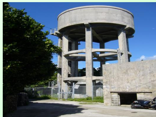
久高高架水槽 90m 3 昭和 52 年建設
