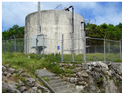
B配水池 RC造 V=183.34\text{m}^3 (昭和52年1月建設)
