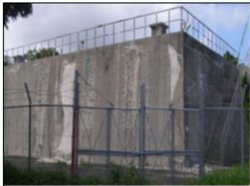
糸数配水池 1,575m 3 昭和52年建設
