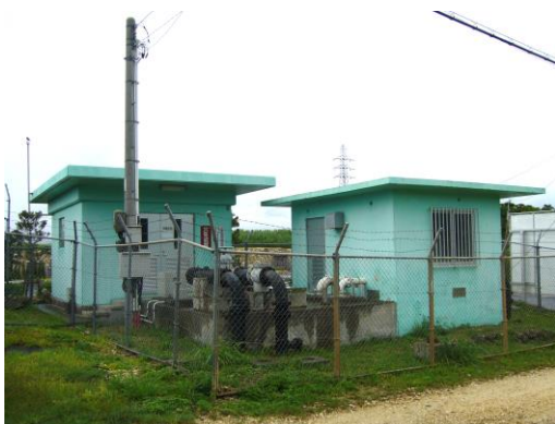
親慶原ポンプ室 RC造
