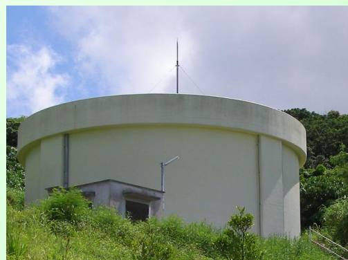
佐敷第2配水池 800m 3 平成10年建設
