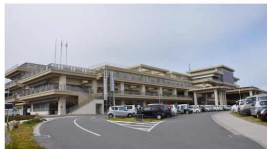
南城市庁舎等複合施設
