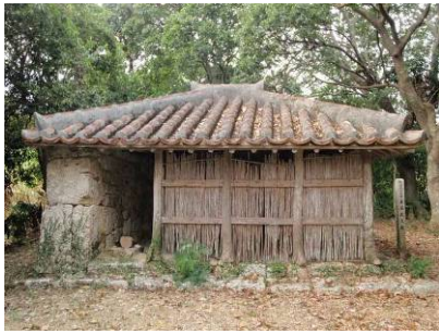
明治期の瓦葺きの状態が残る事例 (佐敷津波古 喜屋武久殿)
