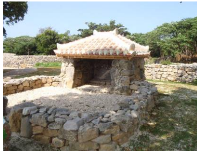
拝殿の石積みを修復し、新規に赤瓦を 設置した事例(今帰仁村)
