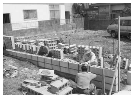
境界線のブロック積み作業で汗を流す
