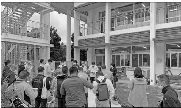
久高幼稚園改修工事
