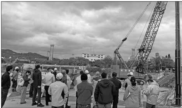
運座新開線(第二新開橋)橋梁架替工事
