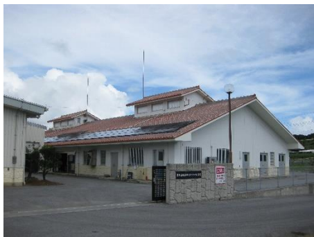
<処理場例>農業集落排水事業玉城第五地区汚水処理場
