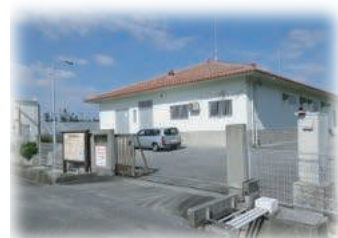
知念東部地区污水处理場
