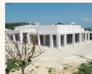
安座真ムラヤー（2015年完成）
