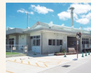
津波古公民館（2011年完成）
