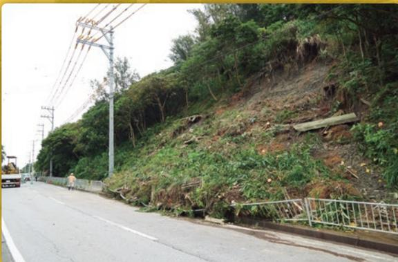
2021年6月17日の大雨では南城市係数で1時間に73mmの雨を観測しました。市内各地で道路の冠水、土砂崩れなどが発生。大里仲間の県道86号線では山の斜面が崩落。土砂が歩道を覆い、ガードパイプをなぎ倒しました。現在、復旧工事が行われています。
