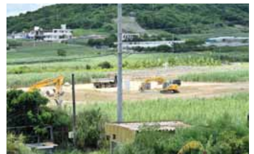
敷地造成工事の様子
