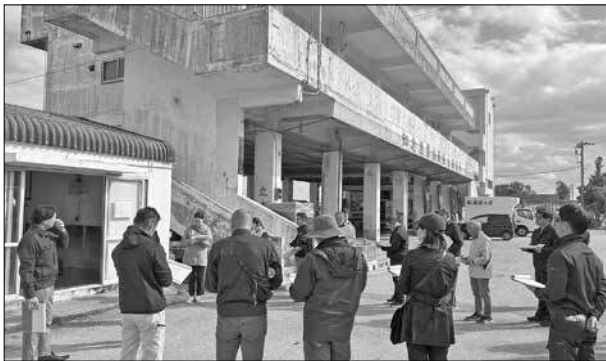
海野 漁業用施設(荷捌施設・水産物展示販売等施設)工事(解体)
