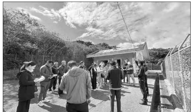
糸数ポンプ場機能増設工事
