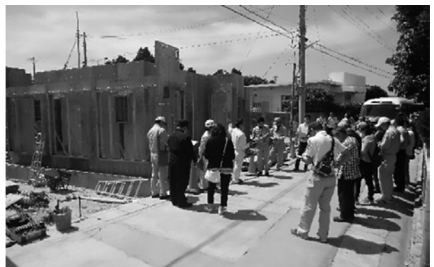
久高診療所看護師宿舎新築工事
