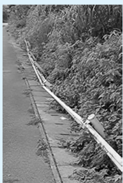
変形したガードパイプ
