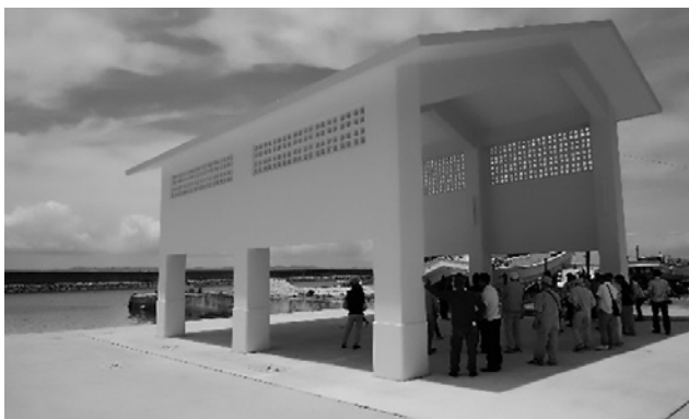
久高漁港防暑施設建築工事
