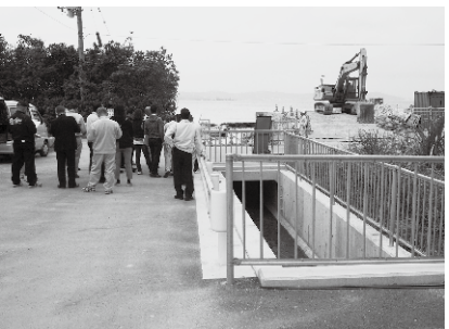
久原農業用排水施設工事
