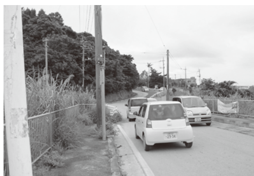
大型車の通行には不便をきたしている県道17号線（湧稲国地域）
