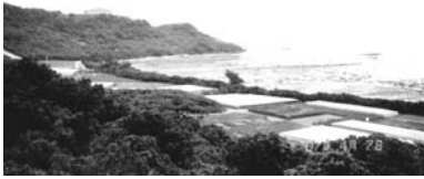
遅々と着手できない久手堅船溜り現場
