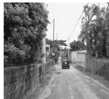
拡幅工事を待ち望んでいる市道8号線
