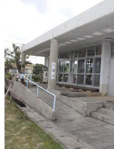
保育園施設外観 (久高島離島振興総合センター)
