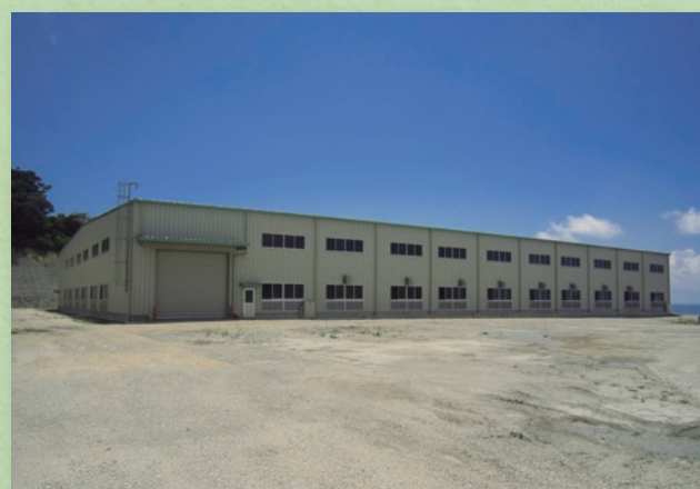
最終処分場建設 工事着手
