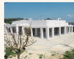
安座真ムラヤー（2015年完成）
