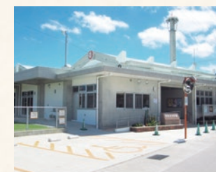
津波古公民館（2011年完成）
