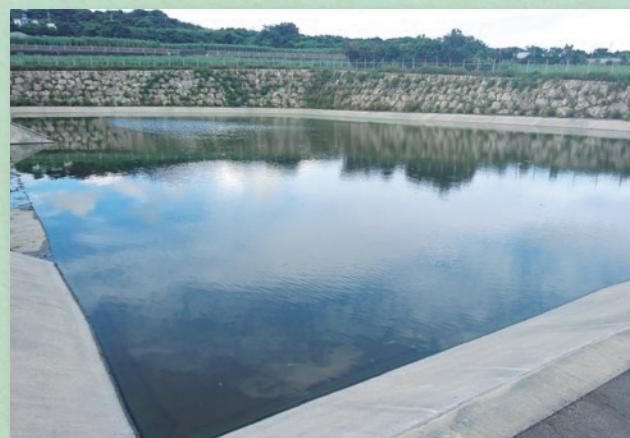
かんがい施設整備（雄樋川1期地区）
