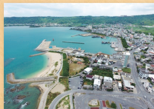
中城湾港（馬天地区）改修事業（県事業）
