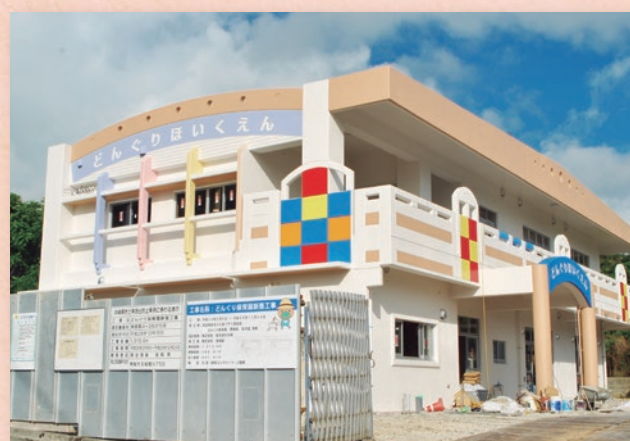
どんぐり保育園 (認可化、建設中)
