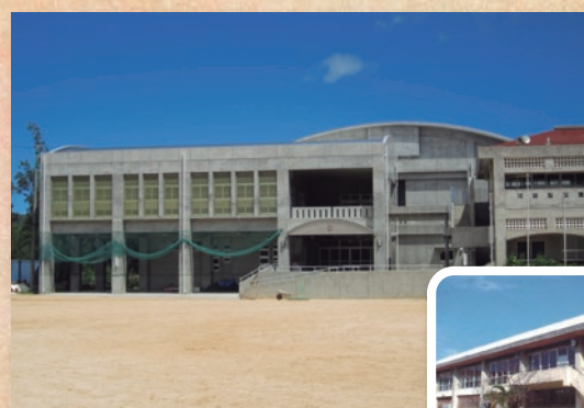
佐敷中学校体育館
