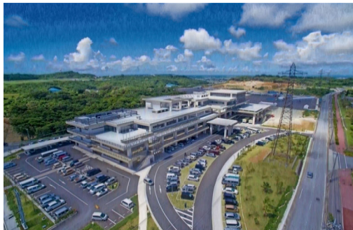
写真 南城市庁舎等複合施設
