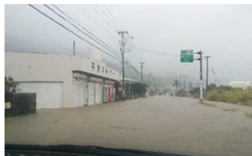
写真 道路冠水の状況
