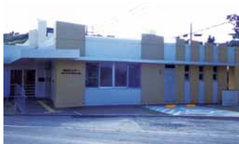
完成した知名むらやー(国道側より)
